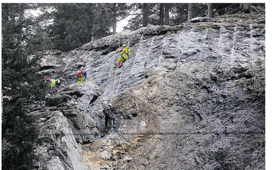
Noch viel zu tun: Während Sprengmeister David Baselgia einen Geologen im Hang kontaktiert, säubern Arbeiter die Sprengstelle von gelockertem Gestein.
