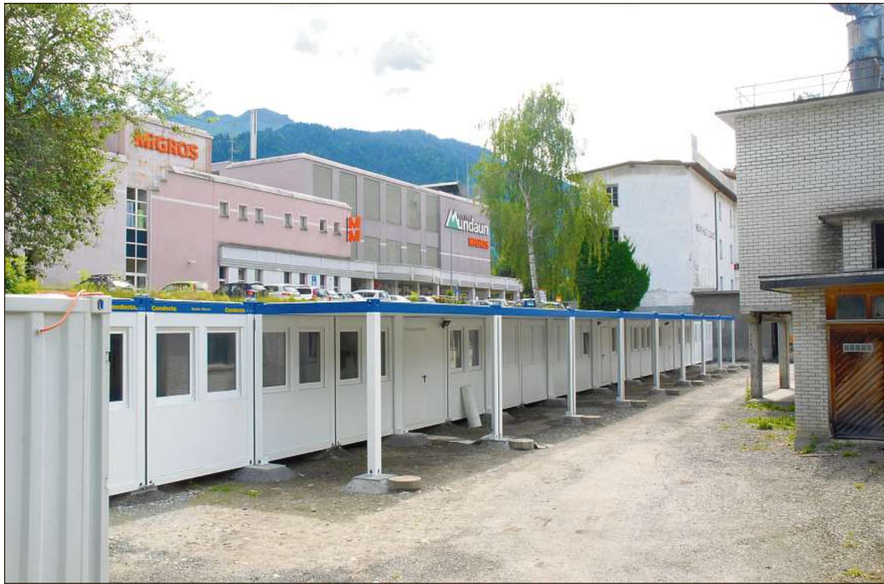
Ils containers ella Via Mulin sut il center Mundaun ein tschentai. Endadens ei il provisorii dalla scola installaus e colligiaus. Las proximas jamnas vegn il plaz avon aunc finius.
